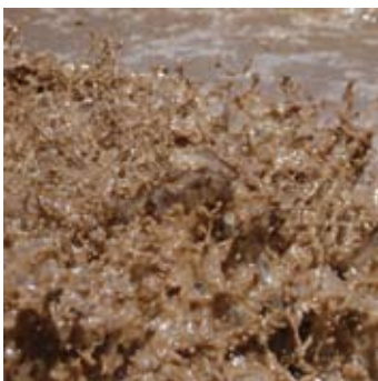
L'étape de l'épuration biologique en pleine phase d'aération
