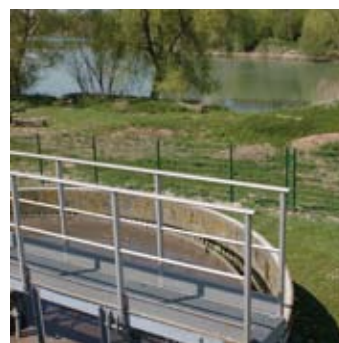
La station est située en bordure de la Marne dans laquelle l'eau épurée est réintroduite.
