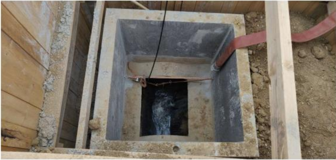
Terrassement et ouverture du regard 120047
