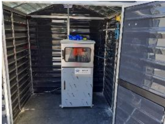
Préleveur en extérieur protégé par un abri
