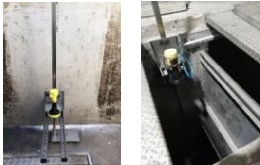
Sondes radar pour la mesure de la hauteur d'eau
