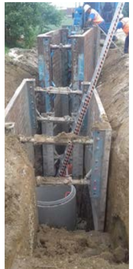
Tranchée de pose de canalisation.
