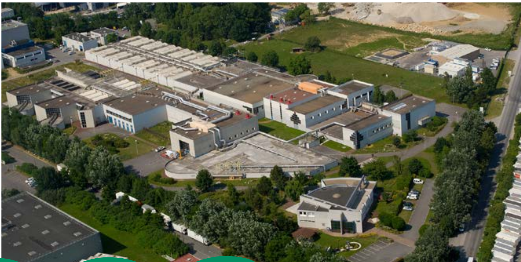
Station d'épuration de Saint-Thibault-des-Vignes.
