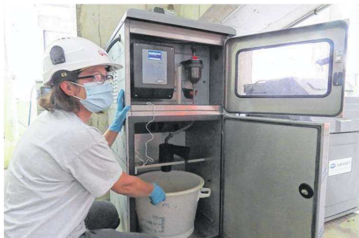
Au Siam, le prélèvement est automatisé. Pendant 24h, la machine prélève une quantité d'eau proportionnelle au débit pour avoir un échantillon représentatif.
