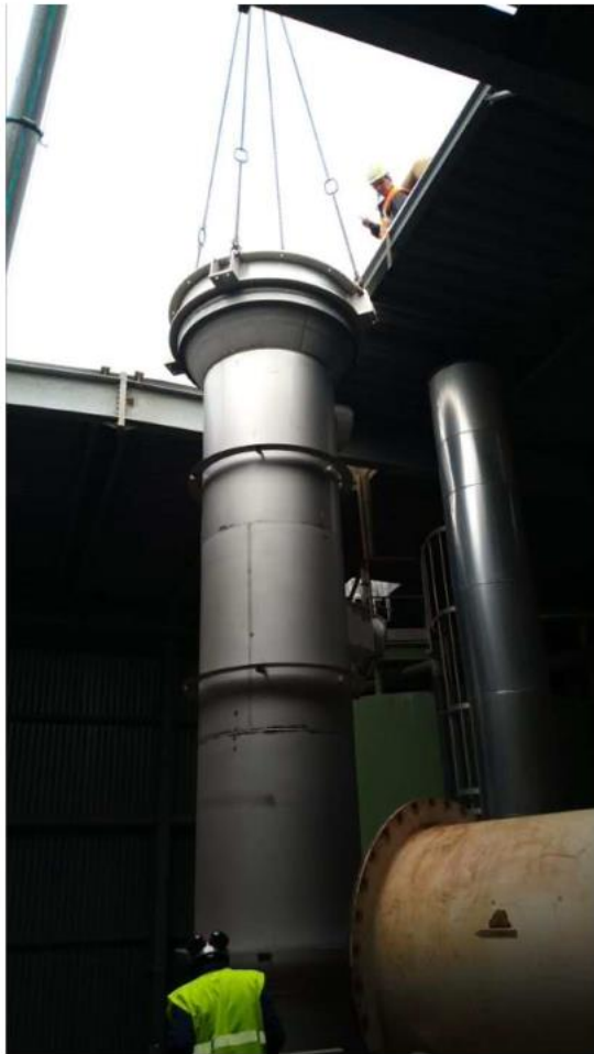
Introduction du nouvel échangeur thermique dans le bâtiment, puis mise en place
