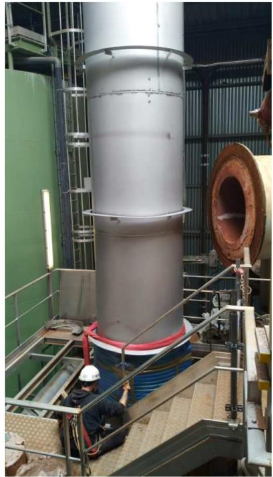
Introduction du nouvel échangeur thermique dans le bâtiment, puis mise en place
